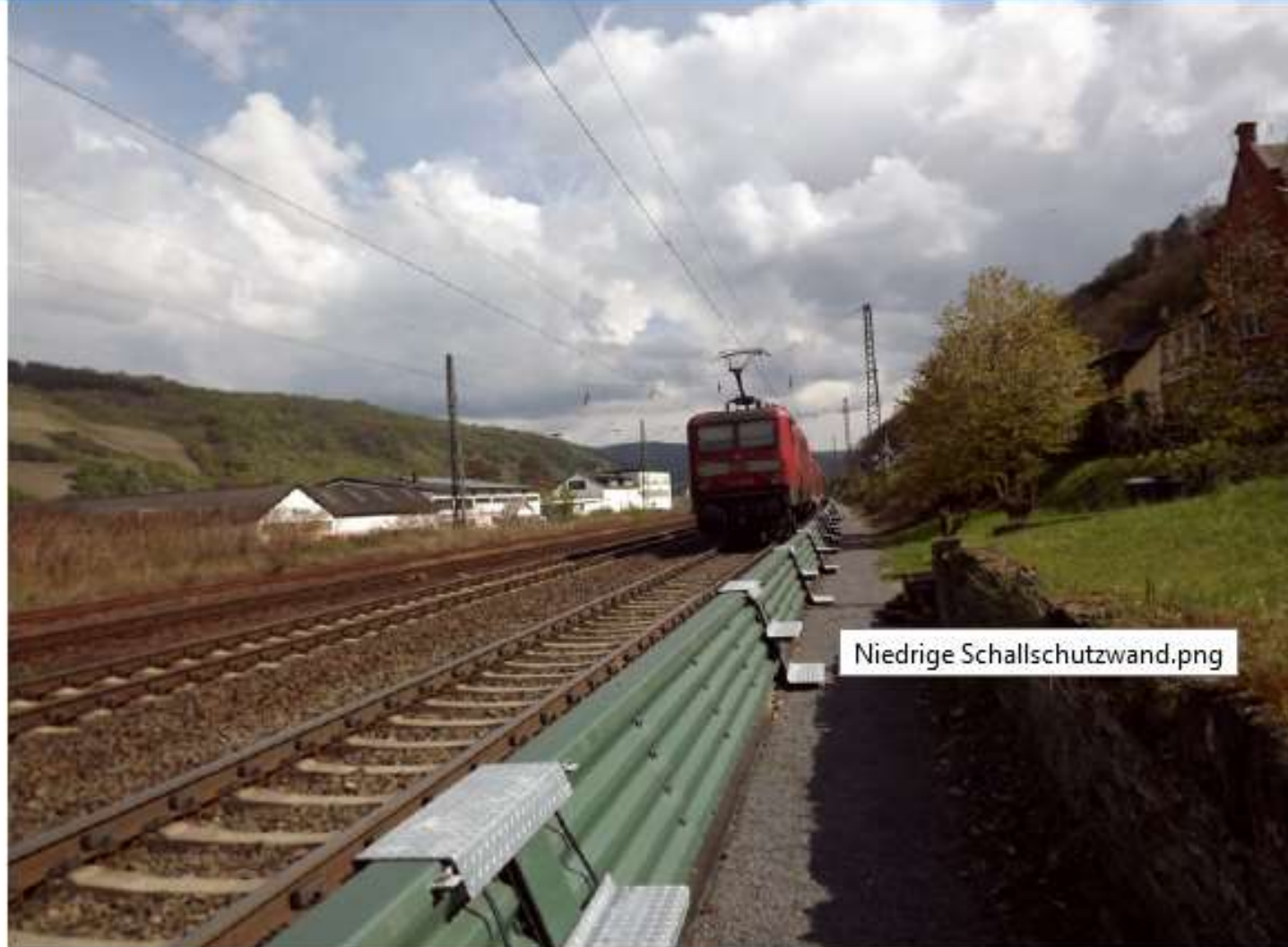
Abb. 3: Schallschutzwand, besonders niedrige Ausführung [DBNAG12b, S. 9]
