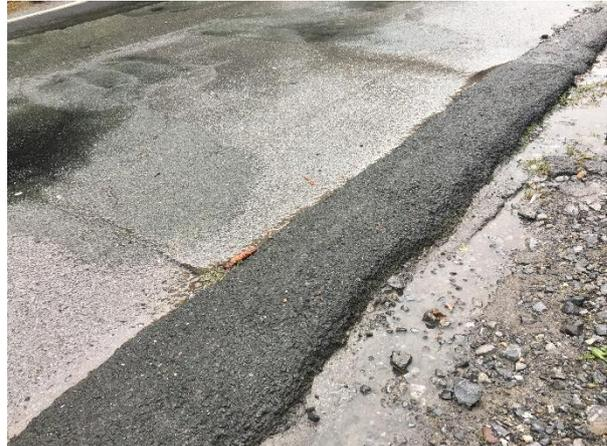
Asphaltwülste leiten dort das Niederschlagswasser, für Fahrradfahrer sind sie aber ein Risiko. Unabhängig von der sicher notwendigen Gesamterneuerung, die bisher an komplizierten Erschließungskostenfragen scheiterten, fordert die BmU ein von der Hauptfahrbahn unabhängiges, sicher benutzbares gepflastertes oder asphaltiertes Provisorium.
